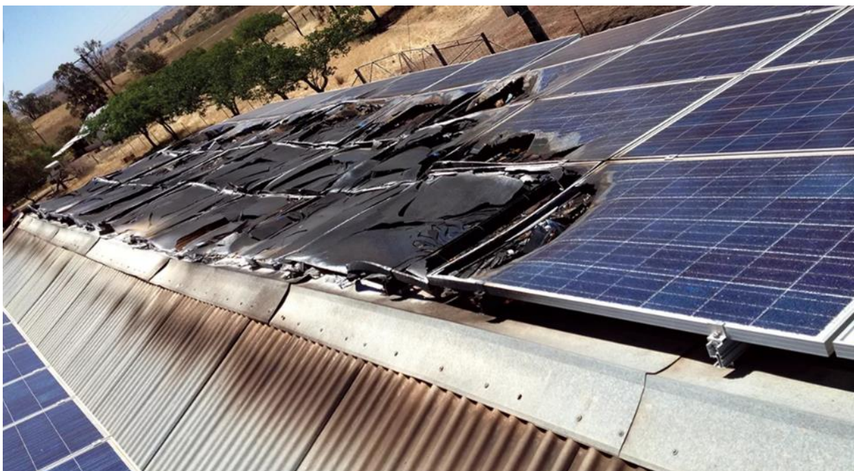
Рисунок 9. Самовозгорание панелей от перегрева. Китай.
