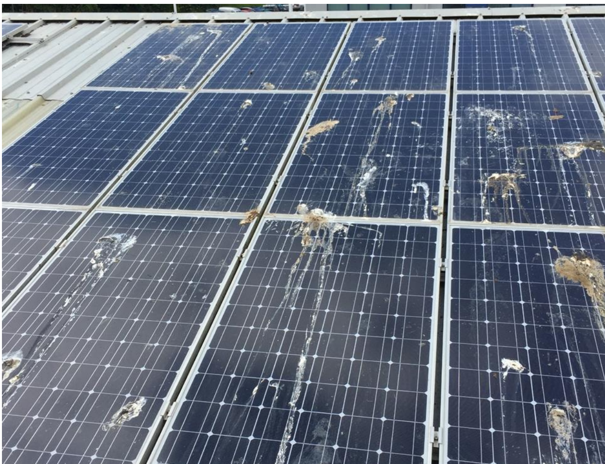
Рисунок 5. Загрязнение панелей птицами.
